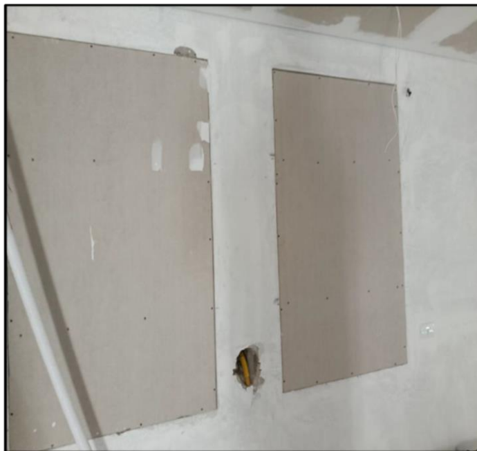
- Isolamento das janelas para redução de ruídos
