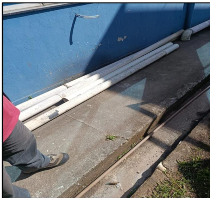
- Tubulação antiga retirada para substituição
