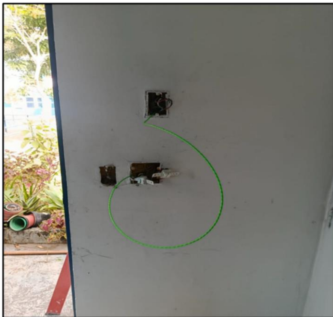
- Cabos instalados, adequação ao projeto elétrico.
