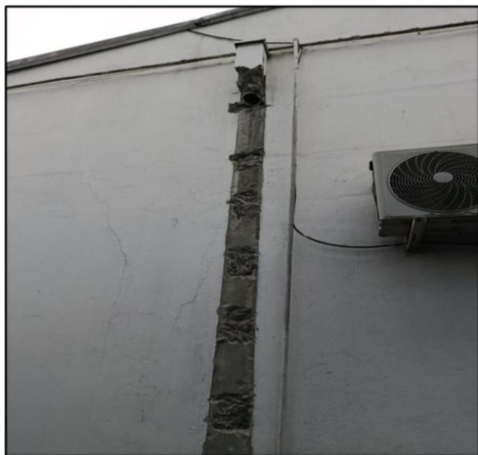
Remoção da estrutura antiga das águas pluviais
