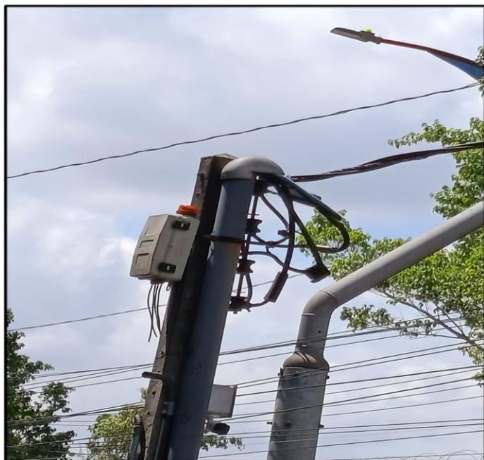
Fotocélula - Acionamento automático da iluminação
