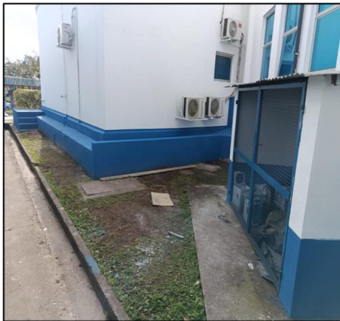
- Panorama externo após execução dos serviços
