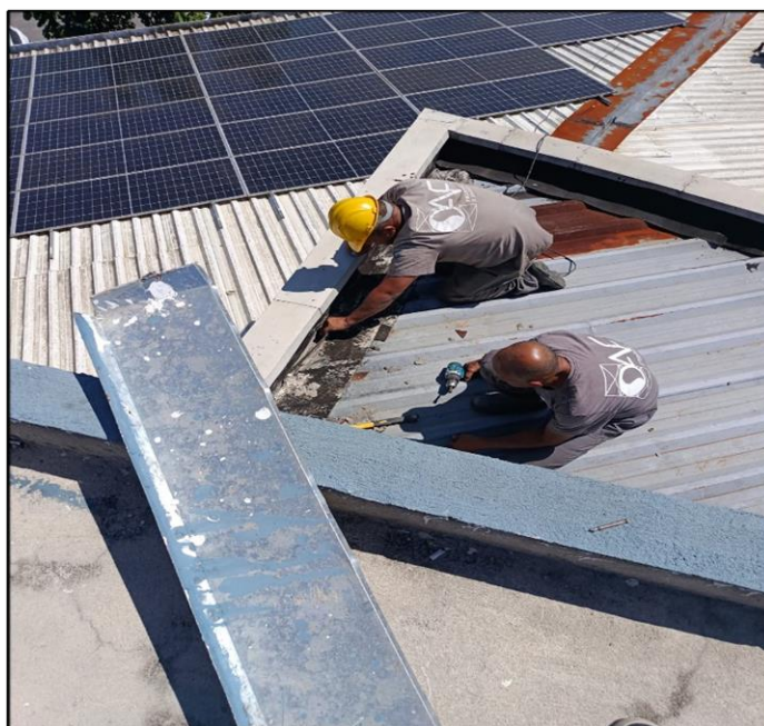
- Manutenção das calhas da fachada
