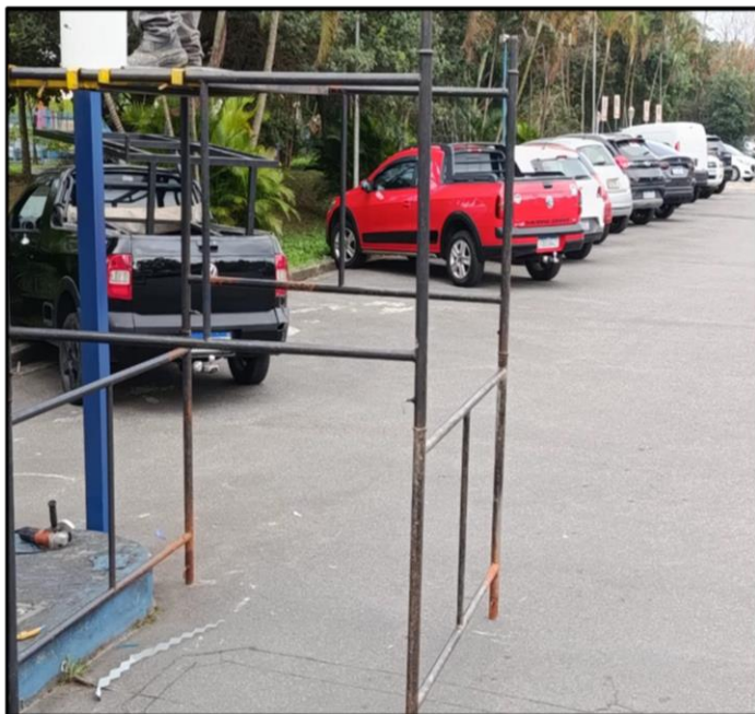
- Andaime para os serviços de manutenção
