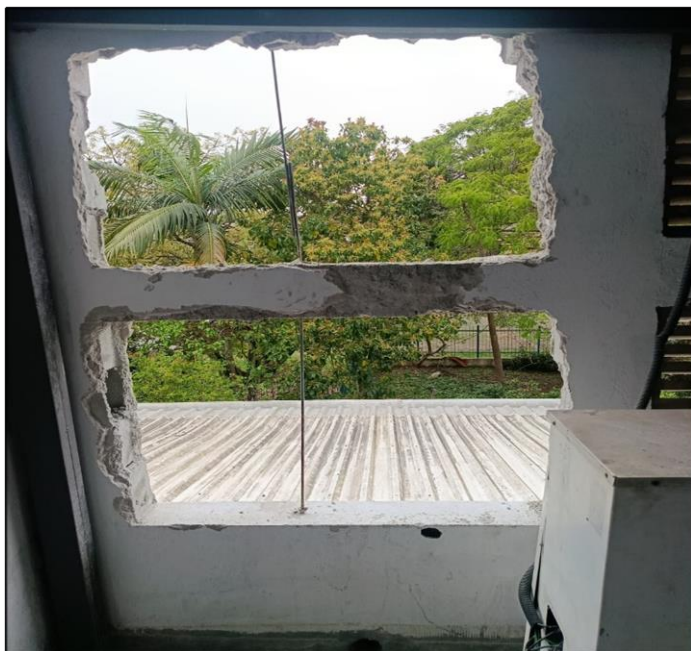
- Instalação de tijolos vazados da casa de máquinas
