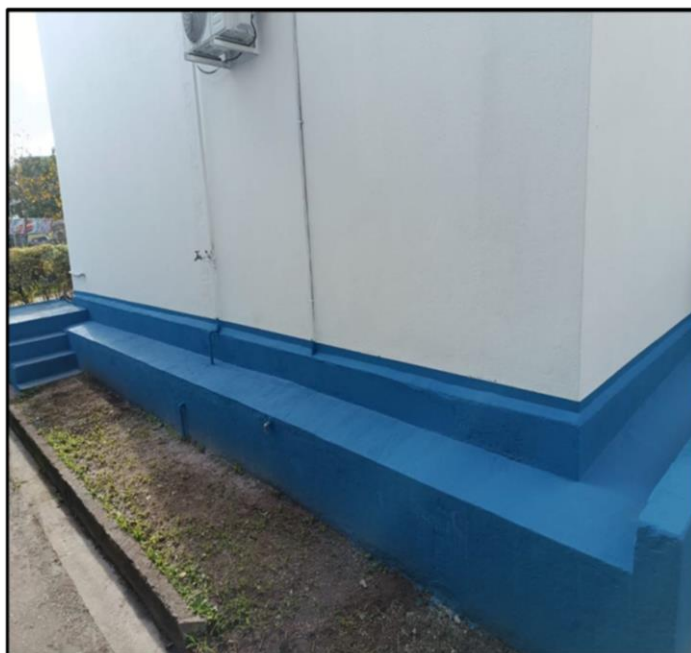
- Vista da jardineira após impermeabilização e pintura
