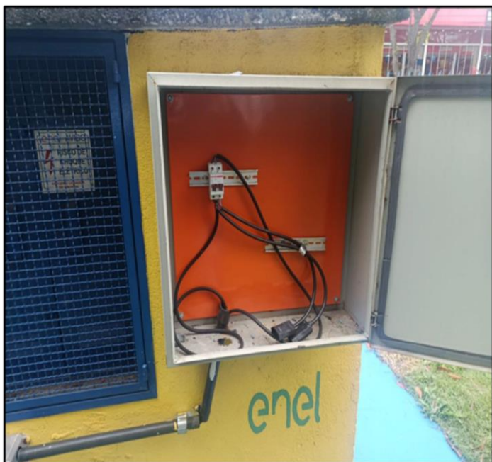
- Quadro com novos disjuntores, cabo "PP" e tomadas
