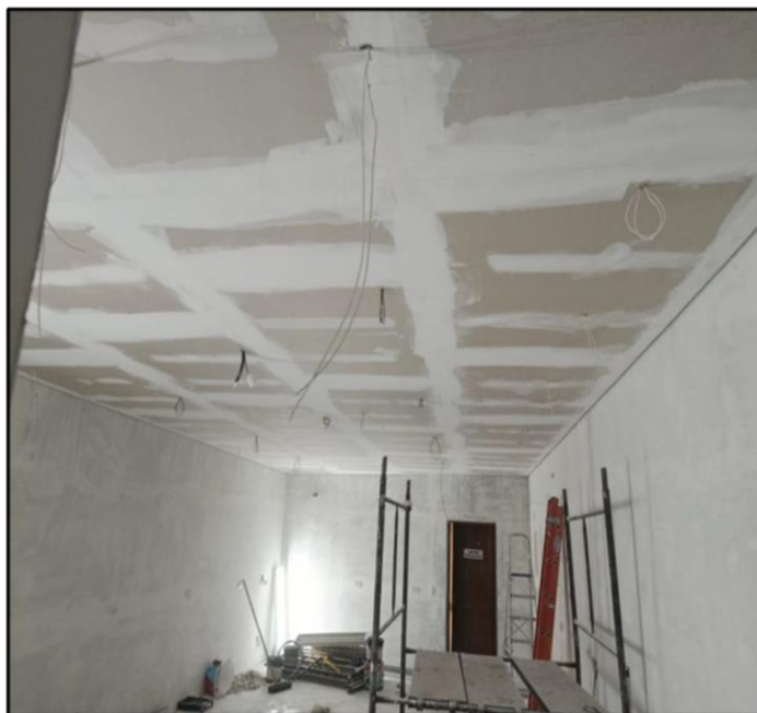
- Conclusão do processo de rebaixamento de teto
