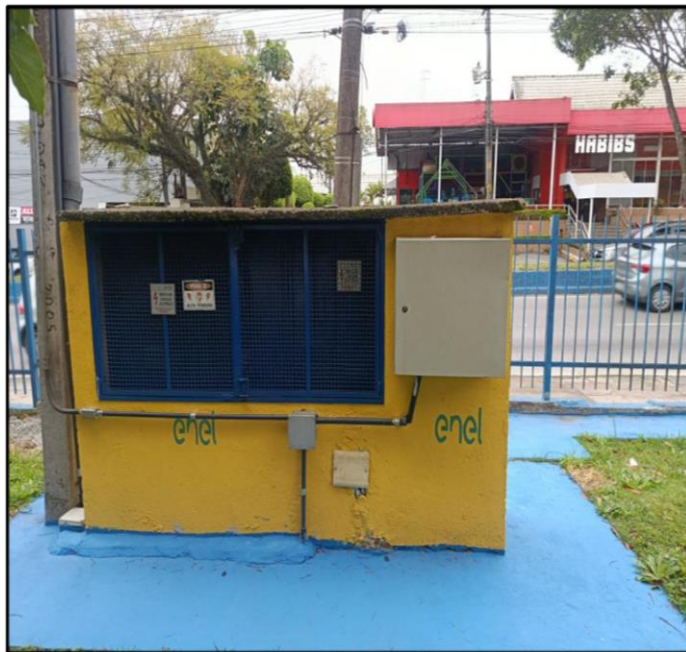
- Caixa de distribuição de energia após manutenção
