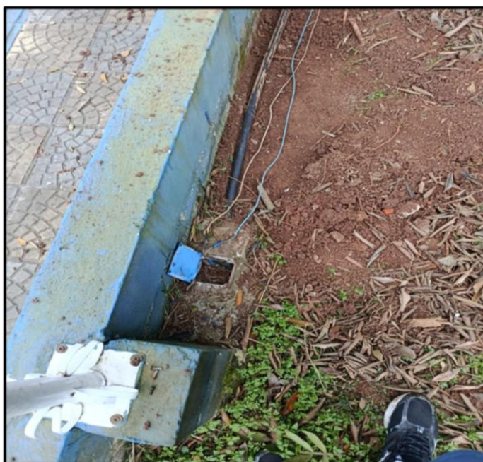
- Passagem de cabos para as luminárias
