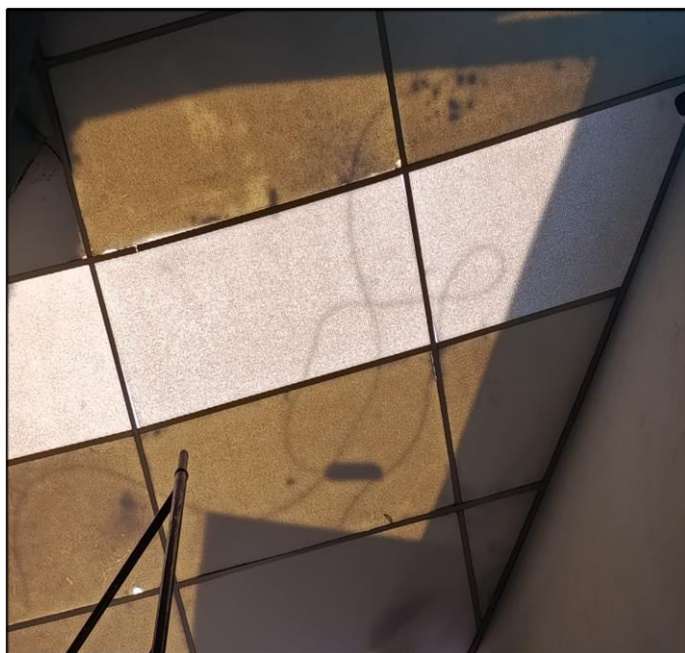
- Reparos no teto da fachada
