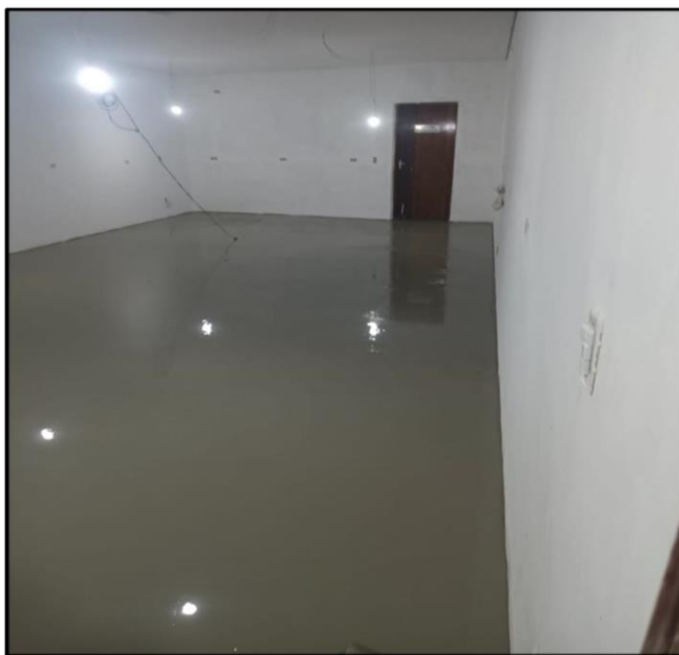
- Contrapiso concluído após preparação da base
