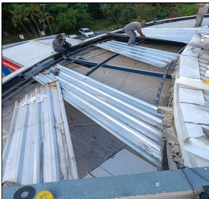
- Remoção das telhas da fachada
