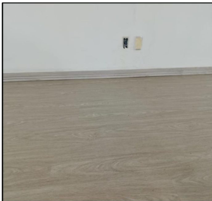
- Instalação do piso, conforme especificações técnicas.
