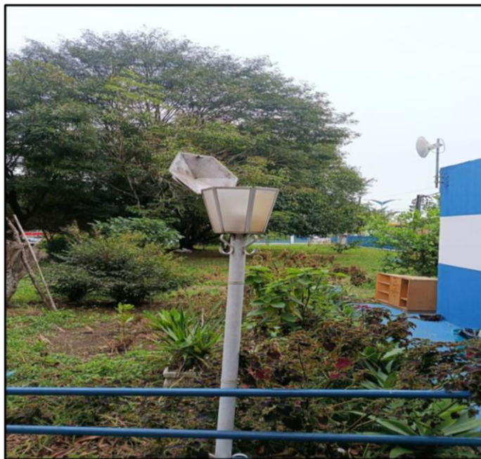
Manutenção em cada luminária externa tipo colonial
