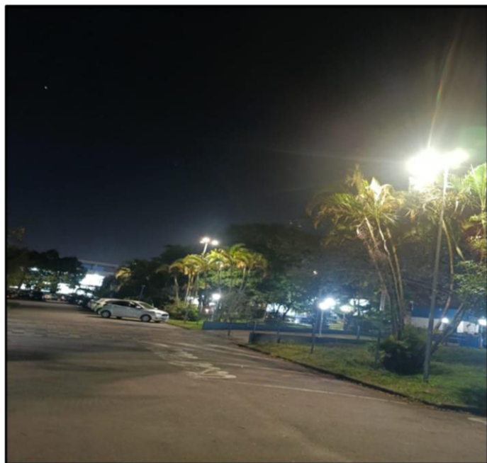
- Postes e luminárias em pleno funcionamento
