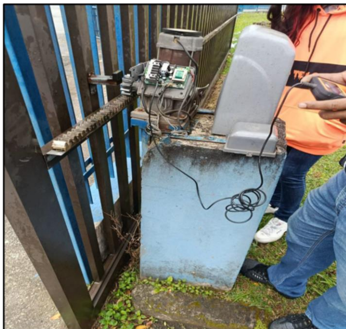
- Manutenção realizada no motor do portão principal
