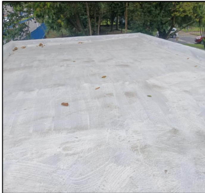
- Manta asfáltica sobre a guarita e sala da jardinagem
