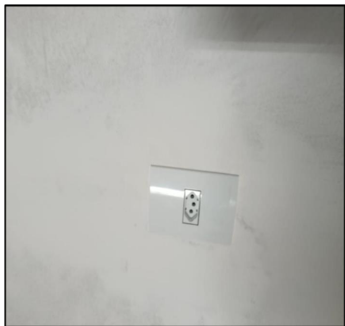
- Instalação dos novos espelhos de tomadas
