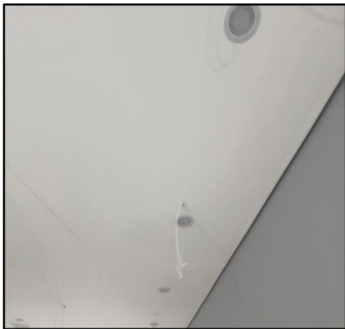
- Novas lâmpadas de LED instaladas
