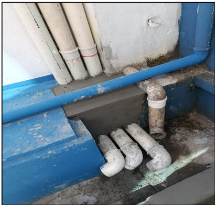
- Novo sistema de drenagem das águas pluviais
