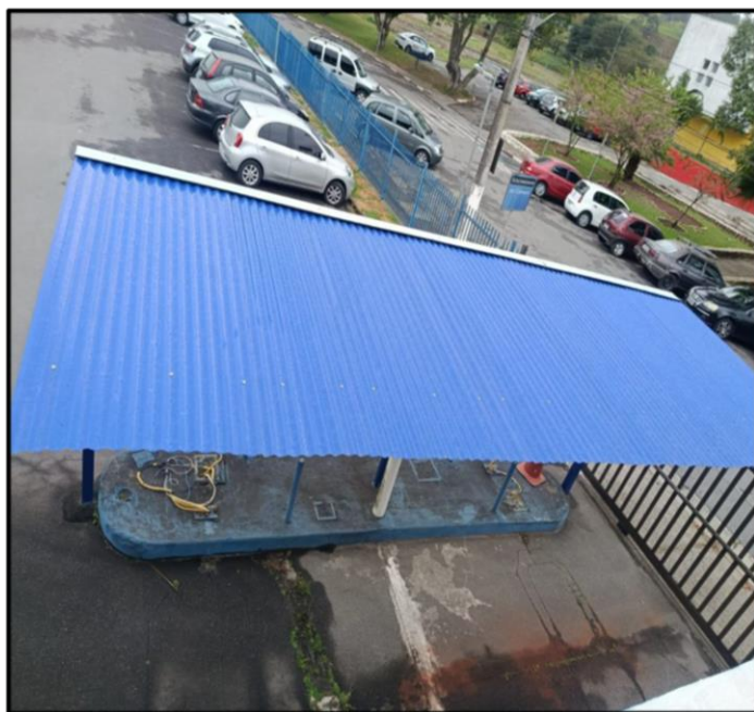
- Novo telhado da cobertura da guarita principal
