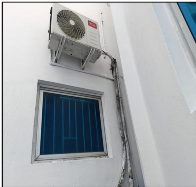
- Ajuste na tubulação do AR - Condicionado
