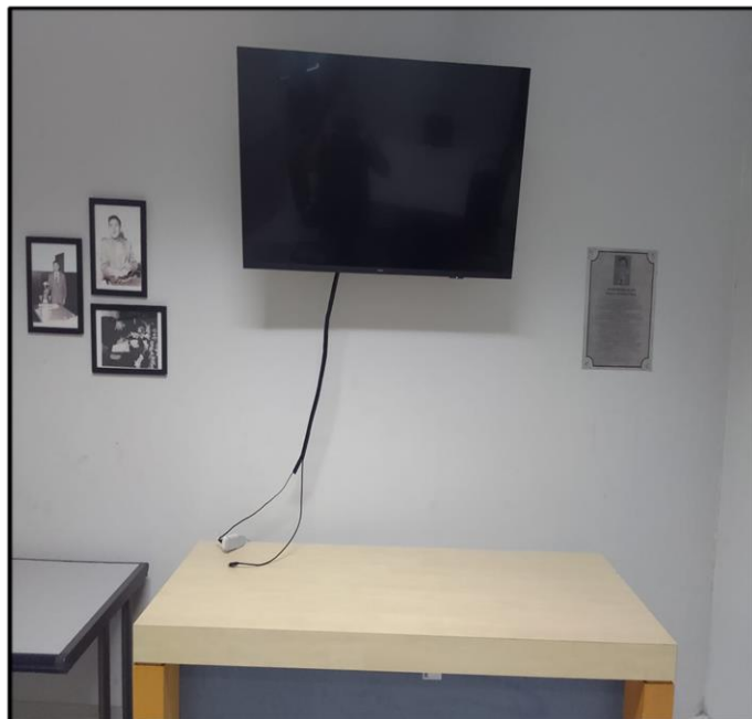
- Instalações de tomadas elétricas
