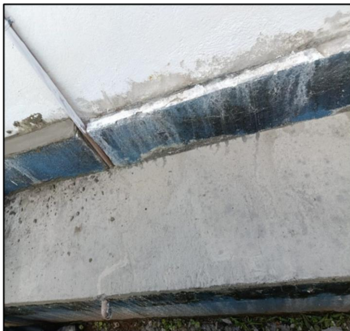
- Vedação final da jardineira após impermeabilização
