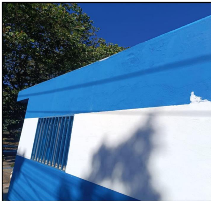
- Serviços de pintura da sala da jardinagem
