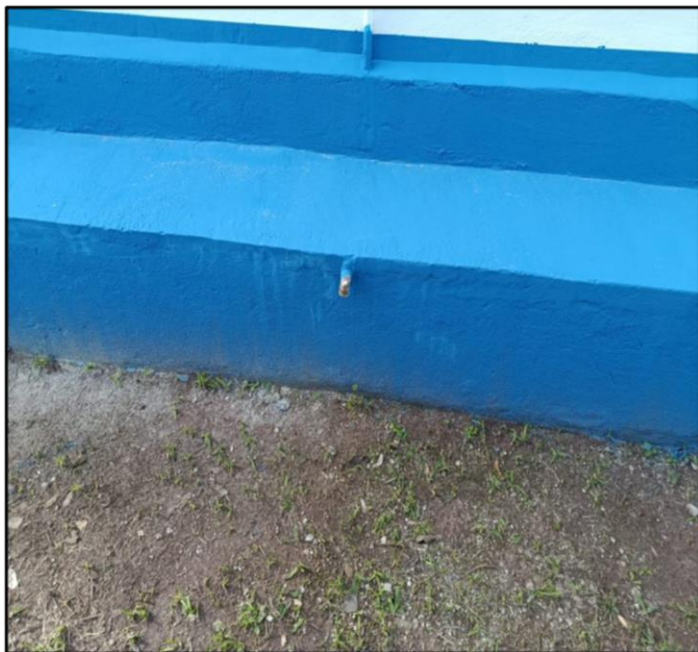
- Correção do dreno - AR- Condicionado
