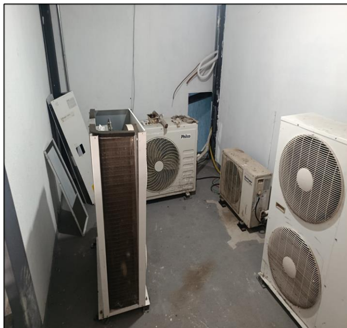
- Vista geral da casa de máquinas
