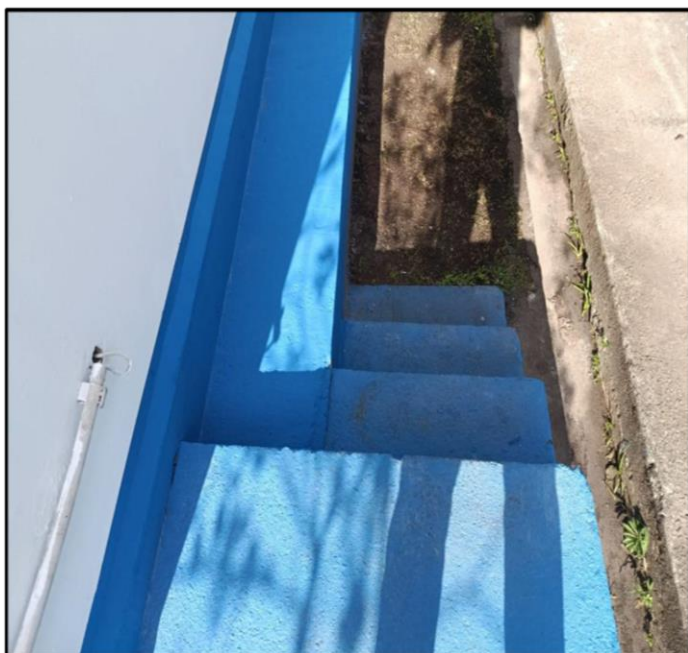
- Aplicação de tinta de piso na escada e na jardineira
