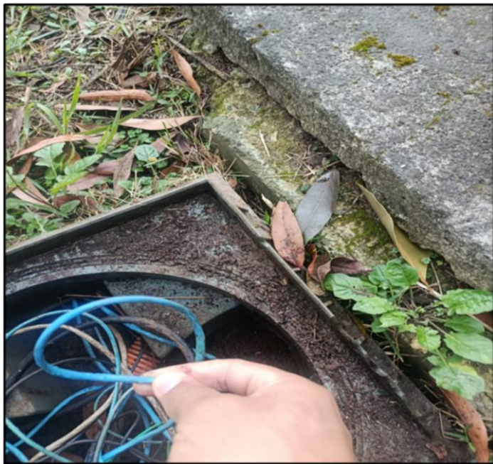
- Novos cabos de rede para interligação das câmeras
