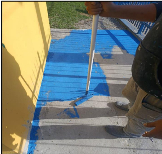
- Execução da calçada junto ao relógio de energia
